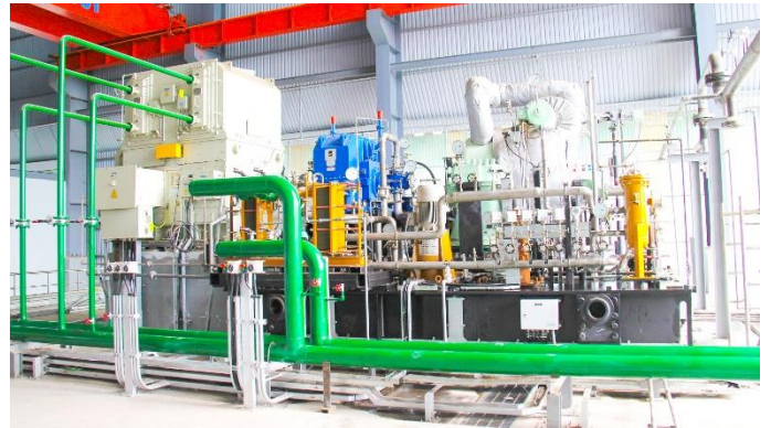
Turbin phát điện 5MW sử dụng nhiệt thu hồi từ lò đốt đã sẵn sàng chờ ngày khánh thành
